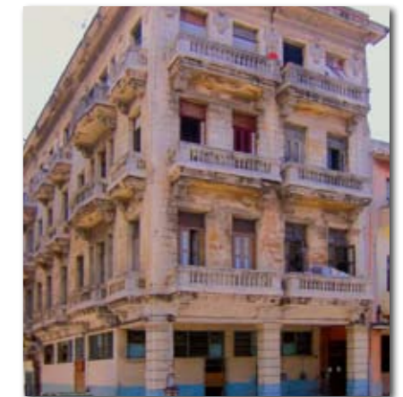
Rechts neben diesem Gebäude befindet sich die Nummer 98. Ähnlich wie dieses Gebäude jedoch könnte die Fabrik damals ausgesehen haben.
